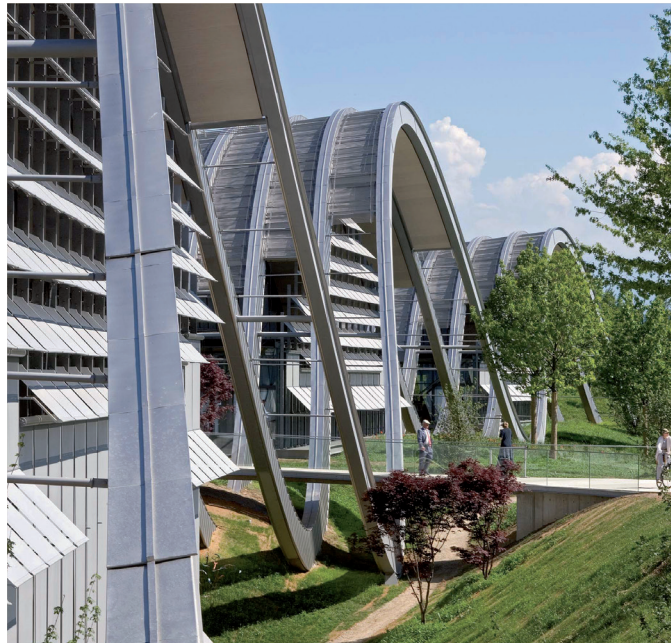
Zentrum Paul Klee, Suisse Renzo Piano Building workshop In Zusammenarbeit mit ARB (Bern) © RPBW – Michel Denancé Ausgeführt mit den Werkstoffen 18-9E, 18-11ML, 304, 316L Oberfläche Uginox Top
